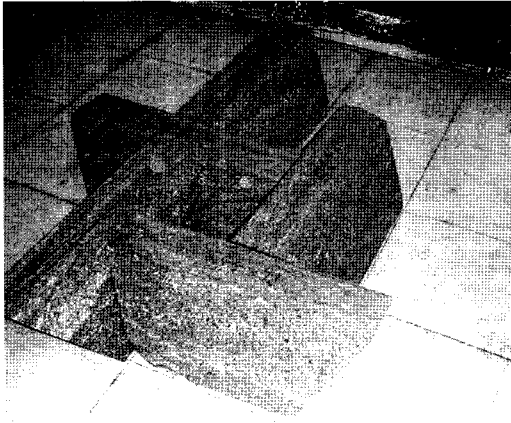
Assembly of first voussoirs
